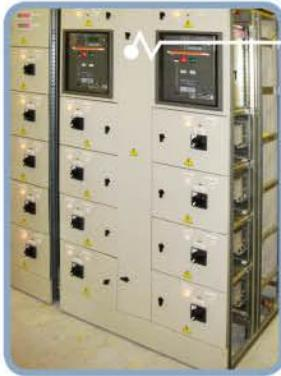
Шкаф отходящих линий с двумя автоматическими выключателями резервного ввода секции 800А и восьмью выключателями до 250А. В верхней части шкафа с фасадной стороны установлены разветвители интерфейса RS485.
