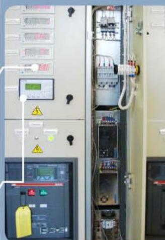
Шкафы ввода и секционирования, кроме того, имеют коммутационные аппараты для питания секций щита. Количество аппаратов секционирования зависит от схемы щита и величины номинального тока секции.
