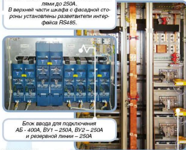
Блок ввода для подключения АБ - 400А, ВУ1 – 250А, ВУ2 – 250А и резервной линии – 250А
